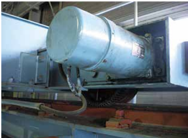
クレーン全体
